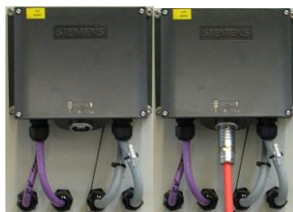
Ilustr.: Caja de conexión sin y con panel conectado
