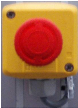
Ilustr.: Pulsador descon. emerg. en caja individual
