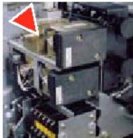
Disparador de abertura Shunt.
