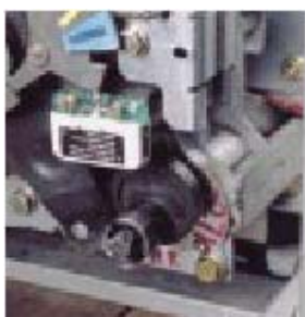
Motor com mecanismo de carga de mola.
