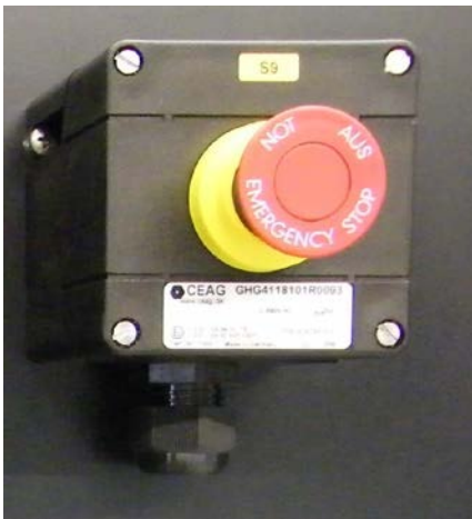
Abb. 2: Not-Halt-Taster
